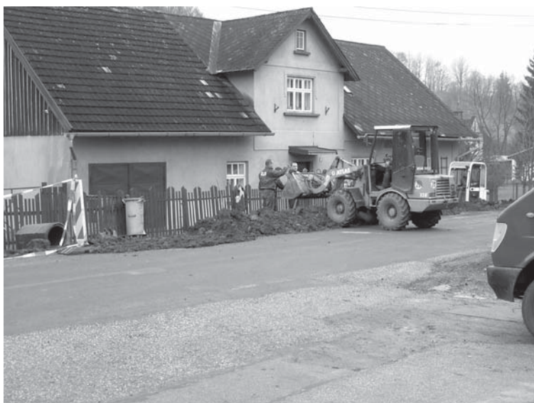
↑ vodovodní přípojky – úsek od st.školy po Bělidlo
