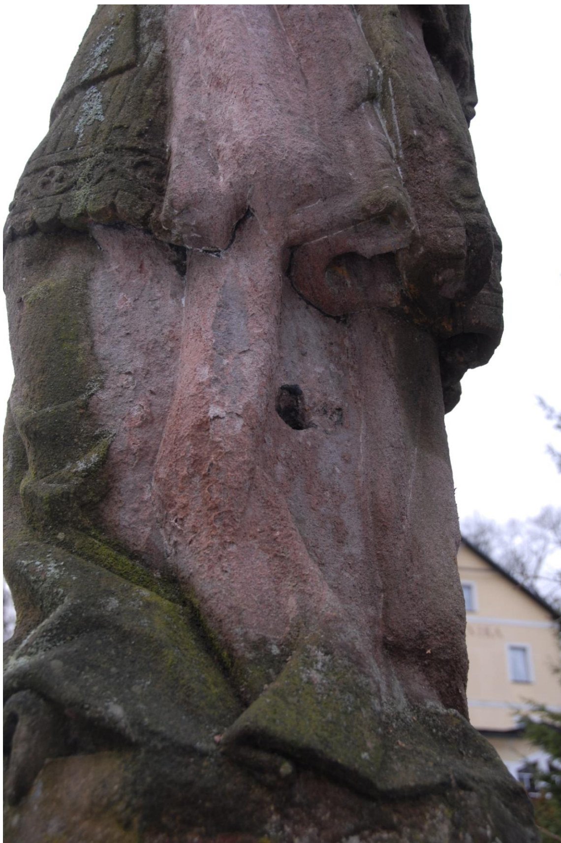
Navětralý materiál na boku světce, otvor se zbytkem olova
